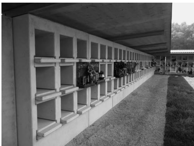
Urnenwand – Überdachung bauseits
